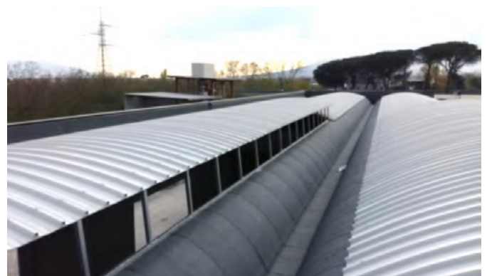
» Couverture entre les éléments « PRISMA » avec panneau sandwich - Vue extérieure
