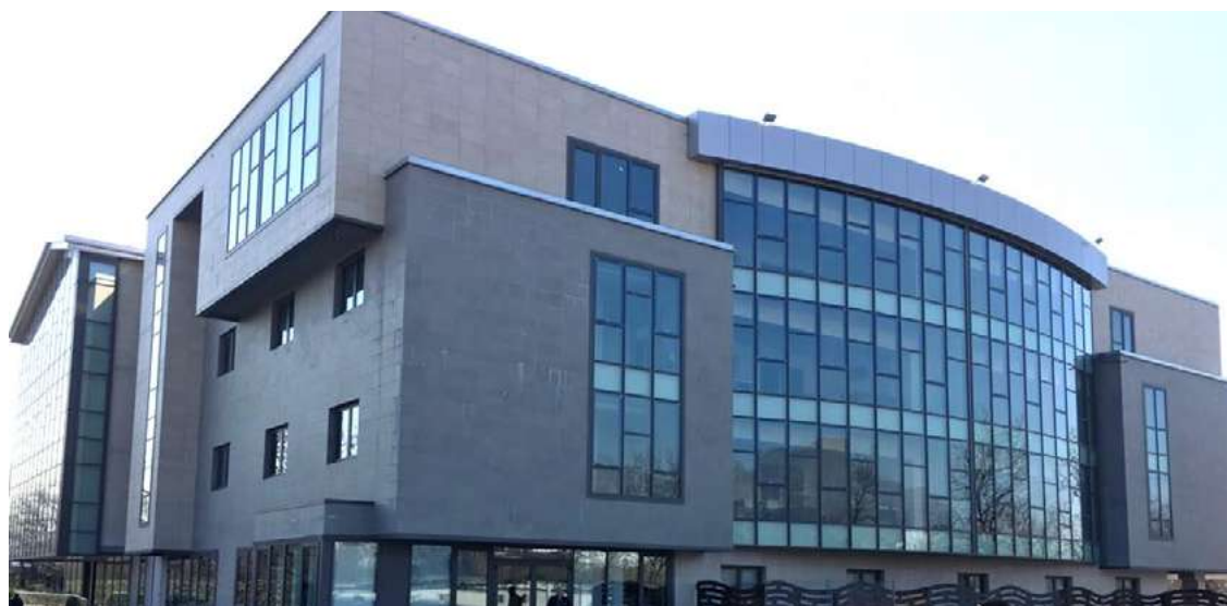
» Vue d'ensemble de la structure achevée.
