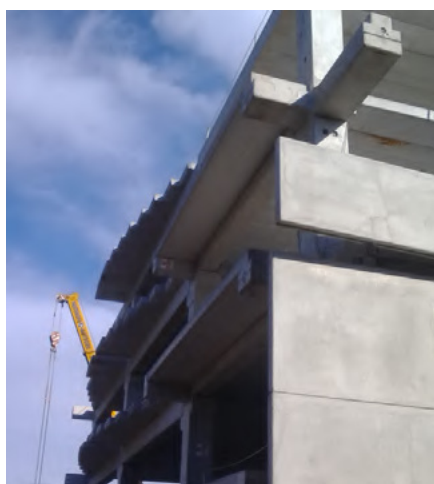
» Structure à plusieurs étages « STRATOS » avec des surplombs et des panneaux.
