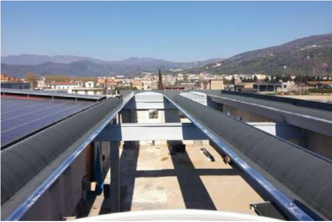
» Éléments « PRISMA » d'imperméabilisation et d'isolation
