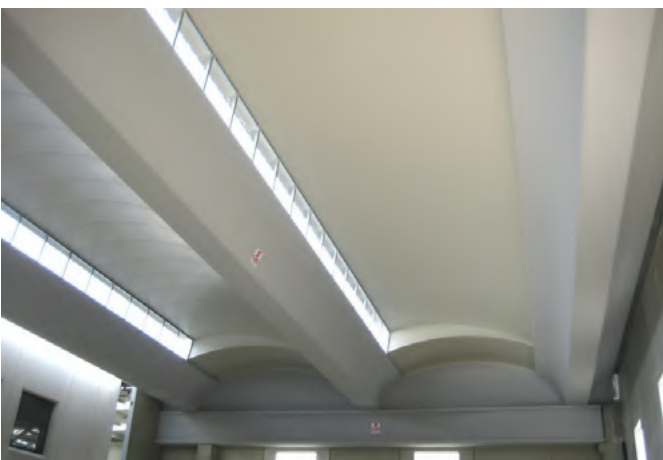
» Couverture entre les éléments « PRISMA » avec panneau sandwich - Vue intérieure
