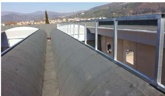
» Éléments « PRISMA » d'imperméabilisation et d'isolation
