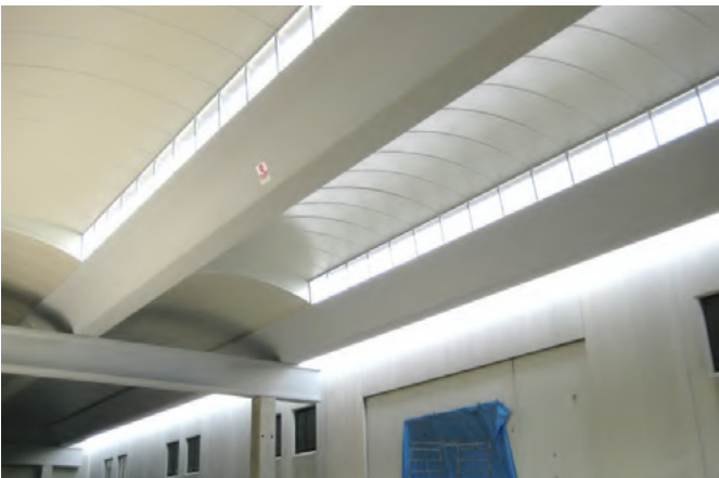
» Couverture entre les éléments « PRISMA » avec panneau sandwich - Vue intérieure
