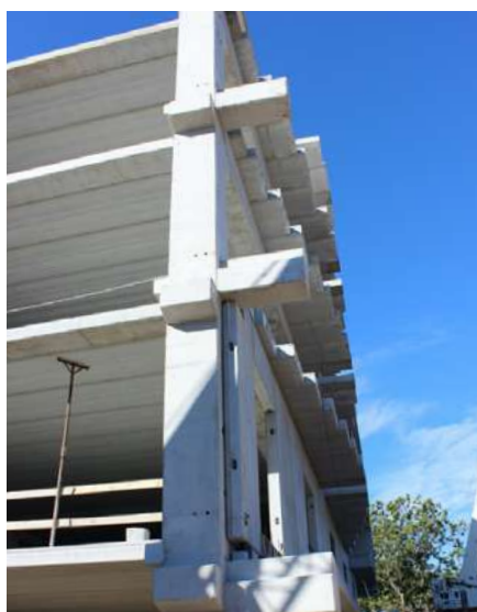
» Structure à plusieurs étages « STRATOS » avec des surplombs et des panneaux
