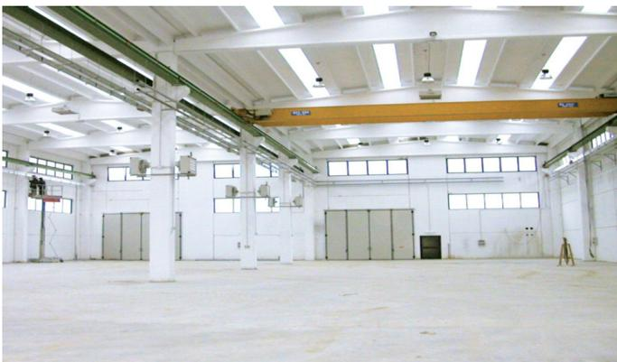
Sistema que identifica una tradición de décadas de prefabricación en el norte de Italia, la viga de doble vertiente sigue siendo a día de hoy la solución óptima para numerosos tipos de edificios.
