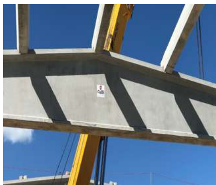
» Particolare dell'appoggio dell'elemento DELTA su capriata.
