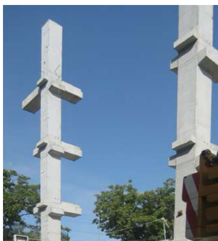
» Pilastri Pluripiani con Mensole e Sbalzi.
