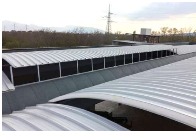
» Manto di Copertura tra gli Elementi "PRISMA" con Pannello Sandwich - Vista Esterna
