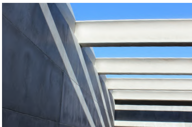
» Elemento "PRISMA" lunghezza 30 mt.
