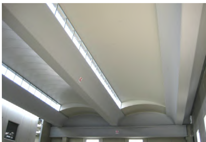
» Manto di Copertura tra gli Elementi "PRISMA" con Pannello Sandwich - Vista Interna
