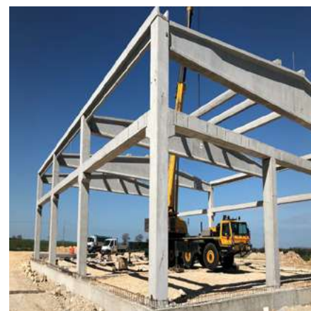
» Particolare della Trave-Gronda Sistema DELTA
