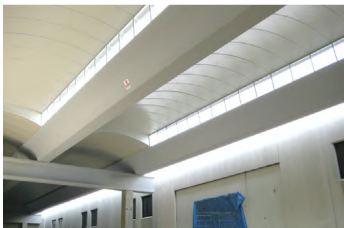
» Manto di Copertura tra gli Elementi "PRISMA" con Pannello Sandwich - Vista Interna
