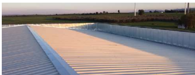
» Particolare colmo esterno copertura sistema DELTA
