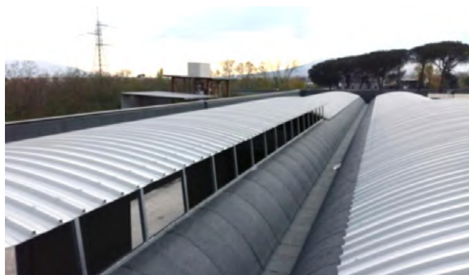
» Manto di Copertura tra gli elementi "PRISMA" con Pannello Sandwich - Vista esterna
