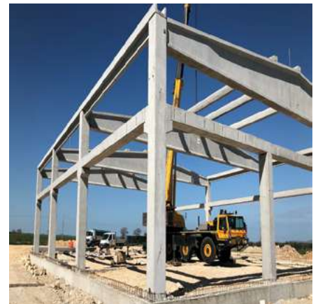
» Detalle del sistema viga-alero del sistema DELTA
