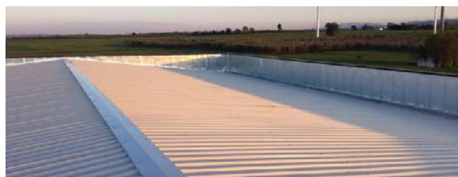
» Detalle de la cumbrera exterior de la cubierta con sistema DELTA
