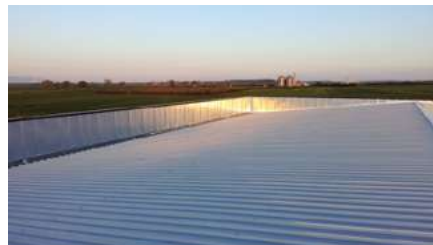
» Vista exterior de la cubierta del sistema DELTA
