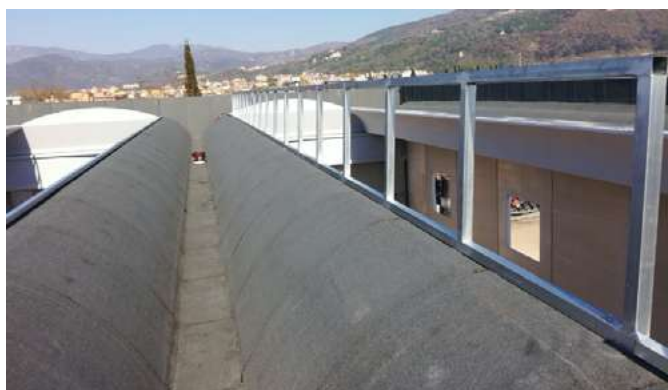
» Impermeabilización y aislamiento Elementos "PRISMA"
