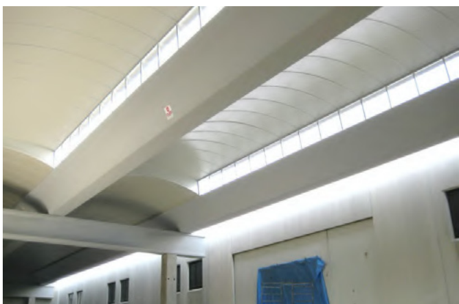
» Cubierta entre elementos "PRISMA" con panel sándwich - Vista interior
