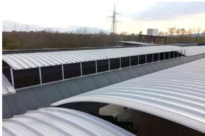
» Cubierta entre elementos "PRISMA" con panel sándwich - Vista exterior
