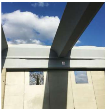
» Soporte "PRISMA" en la viga lateral "ADI".
