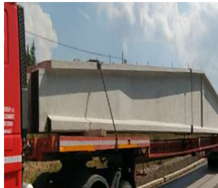
» Transporte cercha para el Sistema DELTA.
