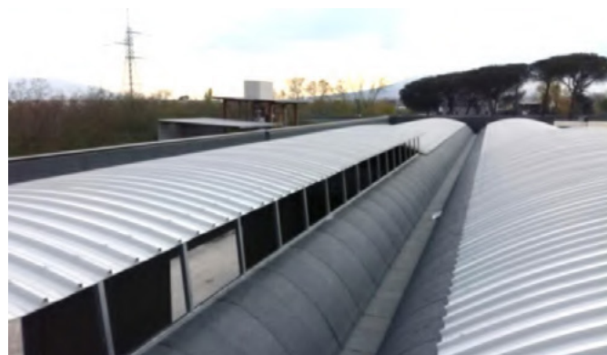
» Cubierta entre elementos "PRISMA" con panel sándwich - Vista exterior
